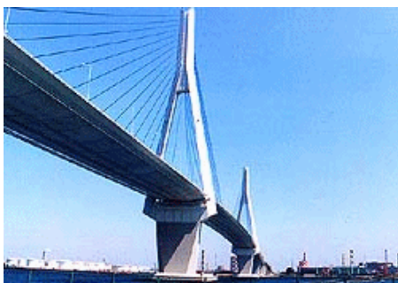
鶴見つばさ橋(斜張橋)
