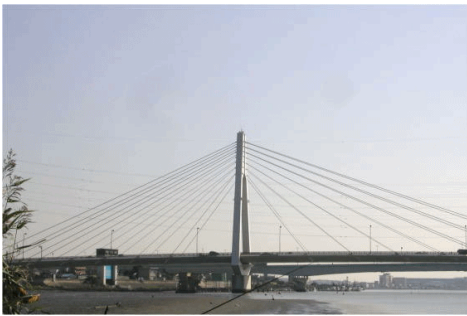
大師橋(斜張橋)
